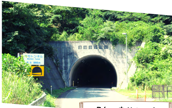
現在の森谷トンネル
